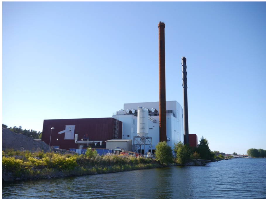
W2E CHP Stegeholm, Västervik, Sweden. 20 MW th , 4,8MW el .
