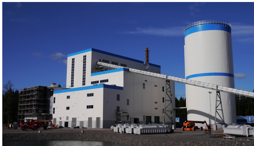
W2E CHP Transtorp, Nybro, Sweden. 22 MW th , 5,3MW el .
