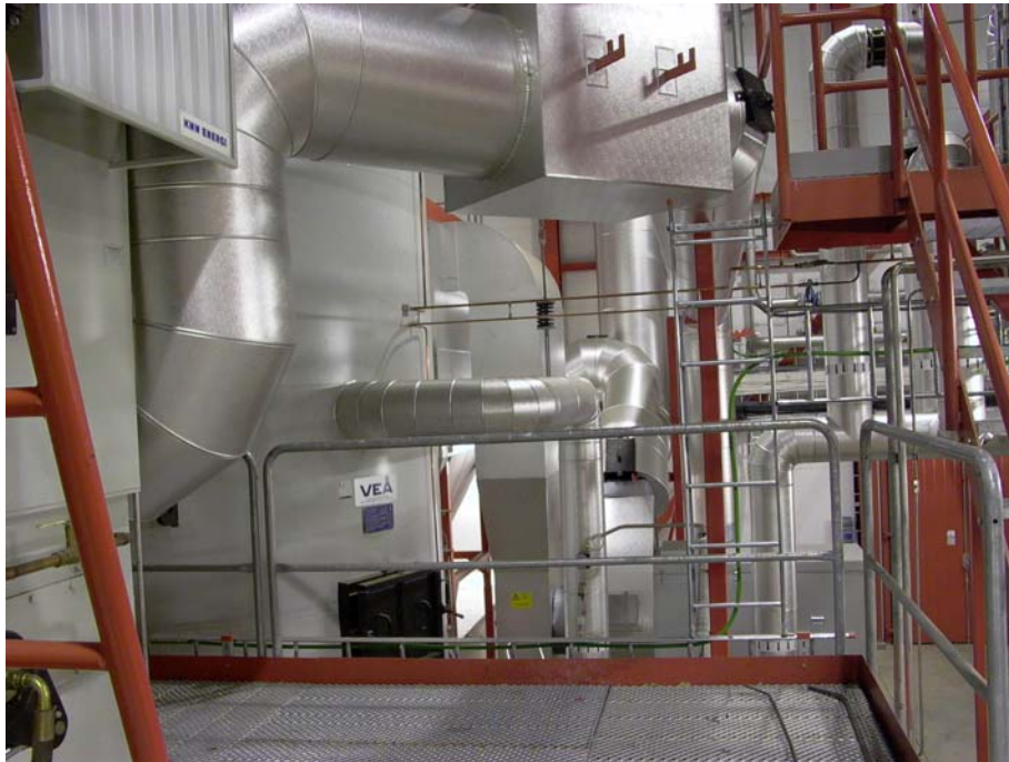
Fjärrvärme och rökgaskanaler för Borgstena Energi AB, Herrljunga. Mindre anläggning.
