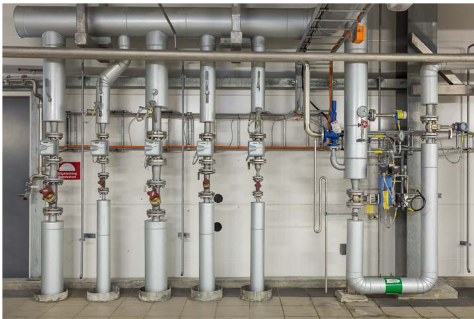
Fjärrvärmeledningar för kylkretsar – KVV Transtorp, Nybro Energi.
