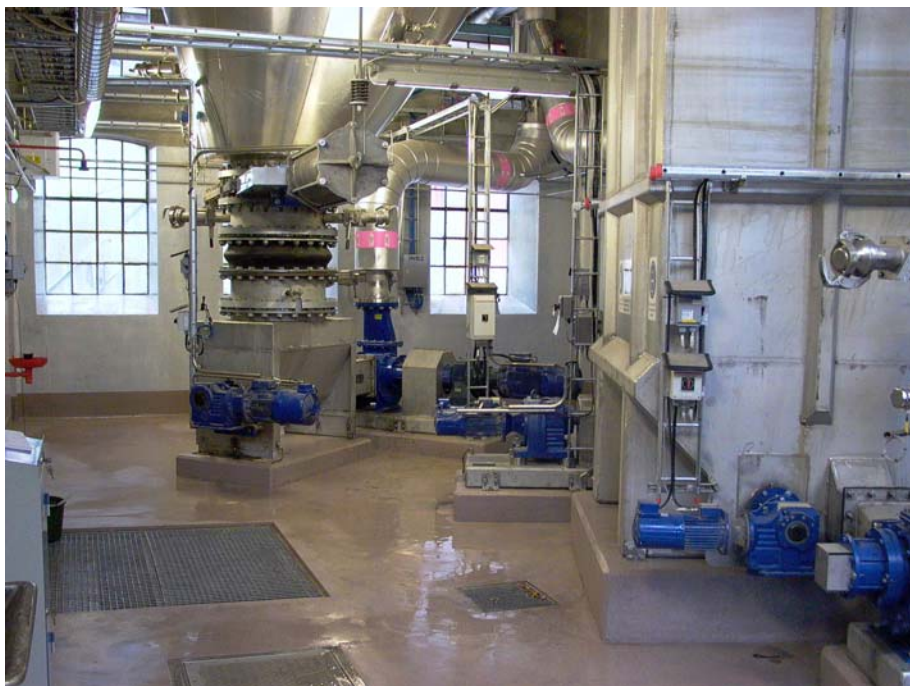
Pumpstation för hantering av slakteriavfall för förbränning – Perstorp Speciality Chemicals, Perstorp.
