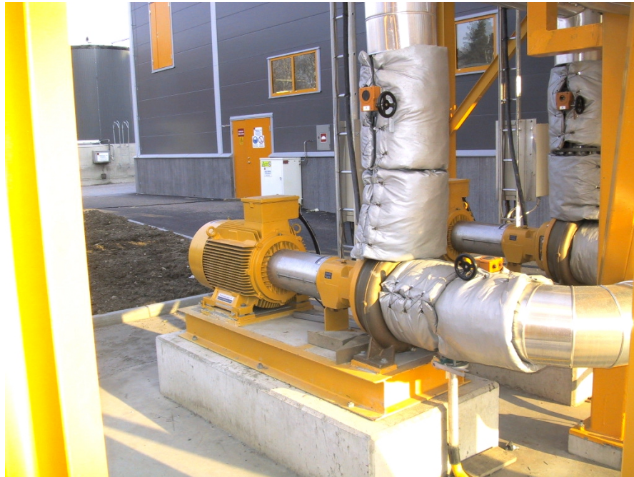
Kondensatpumpar för skrubbertorn – Vattenfall, Götene.
