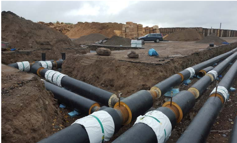
Kulvert för fjärrvärme och hetvatten – KVV Transtorp, Nybro Energi.
