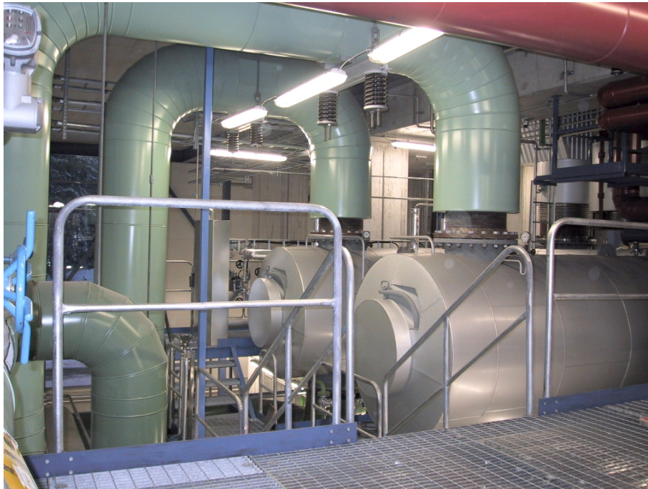
Fjärrvärmeinstallation – KVV Johannes, Gävle Kraftvärme.
