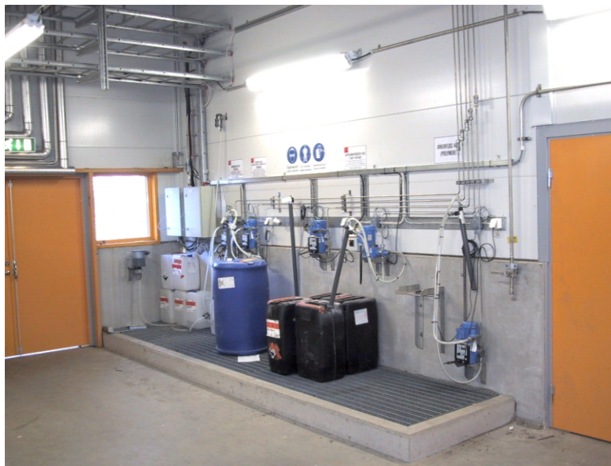
Utrustning för kemikaliedosering till matarvatten – Vattenfall Götene.
