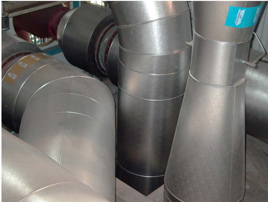
Luft- och rökgaskanaler för avfallsanläggning, Perstorp Speciality Chemicals AB, Perstorp.
