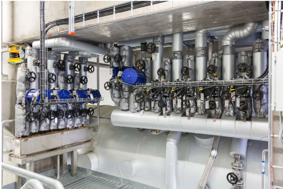
Dräneringsledningar för turbininstallation – KVV Transtorp, Nybro Energi.
