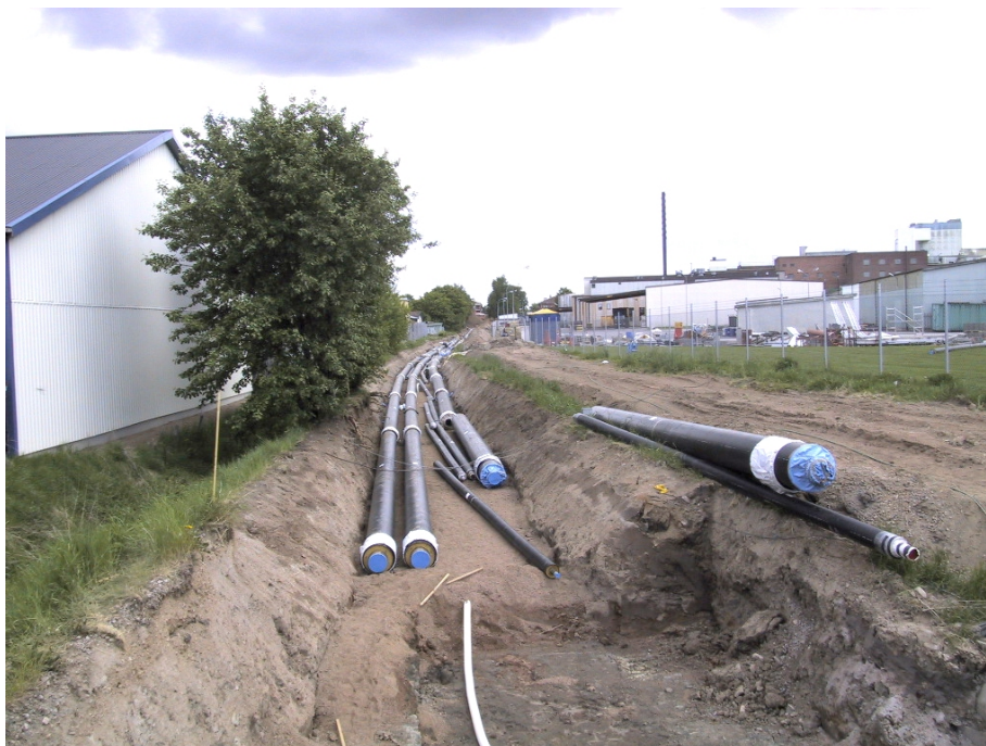
Kulvert för fjärrvärme och högtrycksånga – Vattenfall, Götene.
