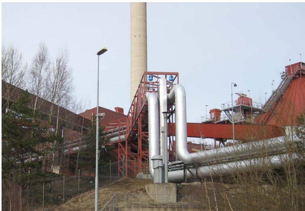
Rörgata med för ånga, fjärrvärme DN900 – Igelstaverket, Söderenergi.
